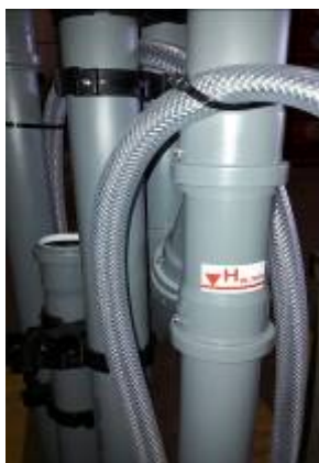
Imagen 8. Altura mínima Digestor 8-10 MS
