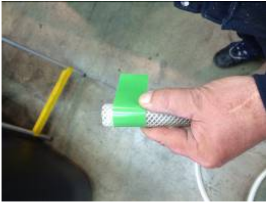
Manguera que se conectará a la identificada en color verde del air-lift
